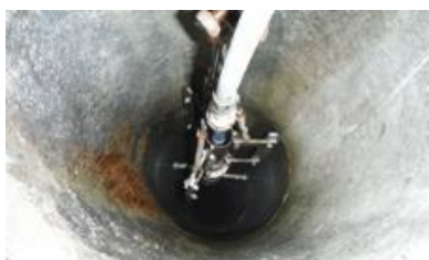
石綿除去作業 (レベル2煙突断熱材)
