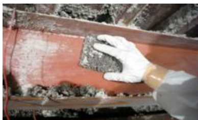
石綿除去作業 (レベル1吹付け材)
