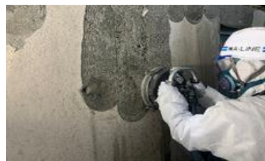
集塵装置付き超高压水洗工法 (レベル3対応工事)
